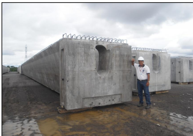
Figura J.10. Vigas pretensadas en sitio de espera.
