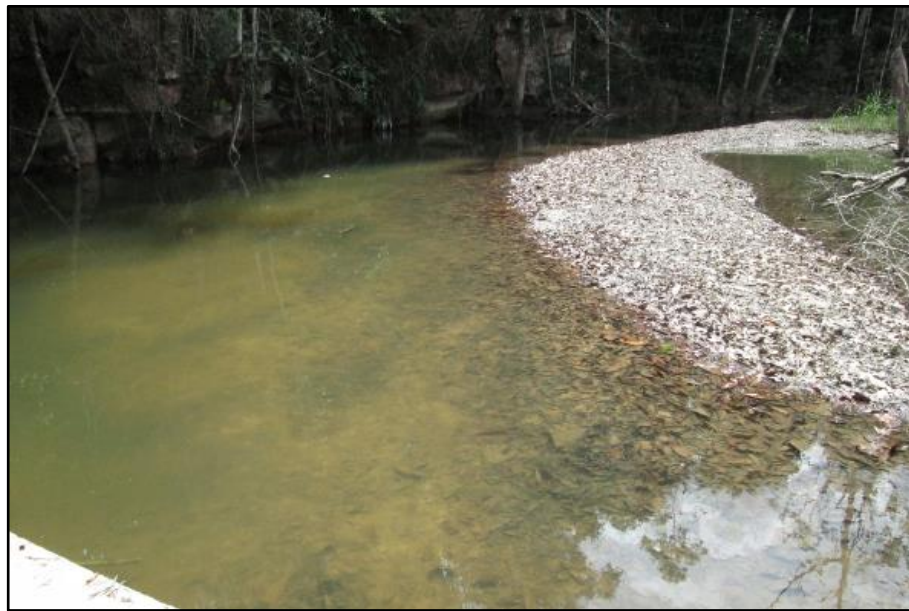
Figura 5.18 Acumulación de sedimentos en la ribera izquierda del embalse Wará II.
