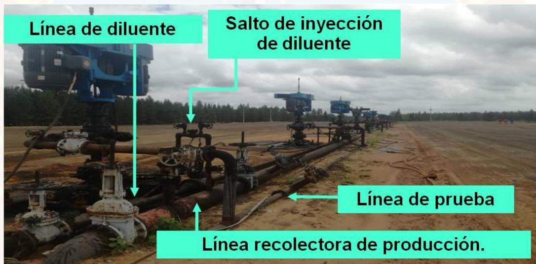
**Figura 4.8. Macolla con facilidades temporales con inyección en línea recolectora.**
