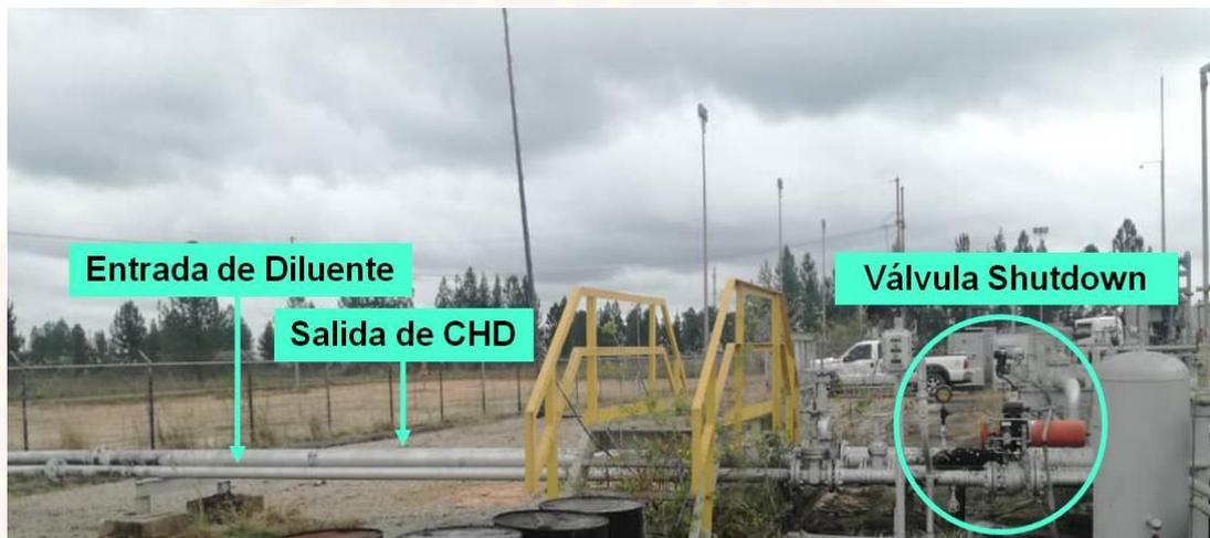
**Figura 4.5. Línea de entrada de Diluyente en la Macolla con facilidades permanentes.**
