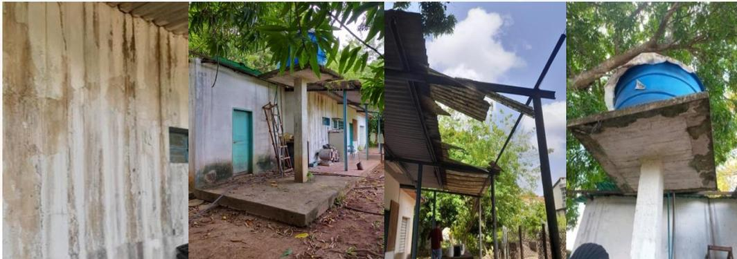
**Figura 8. Área de servicio con falta de mantenimiento y tanque elevado en desuso.**
