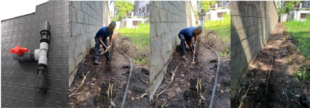
**Figura 39. Material disponible y excavación para reguardar tubería en área externa.**
