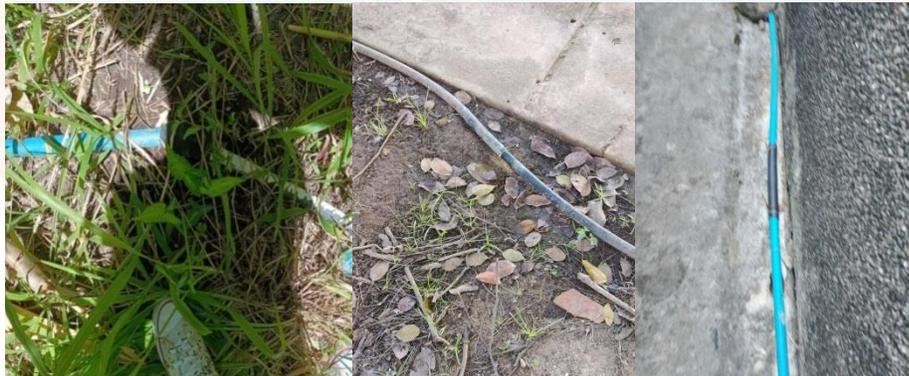
**Figura 20. Conexión con goma de caucho y uniones improvisadas en la red principal (F1) de distribución de agua.**
