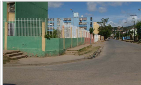
Imagen IV.43. Vista Vialidad de Tierra
