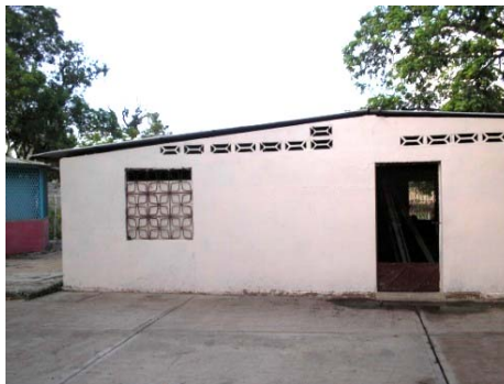
Figura n° 45. Lavadero de las Hermanas de la Consolación-deposito de la Casa Hogar.
