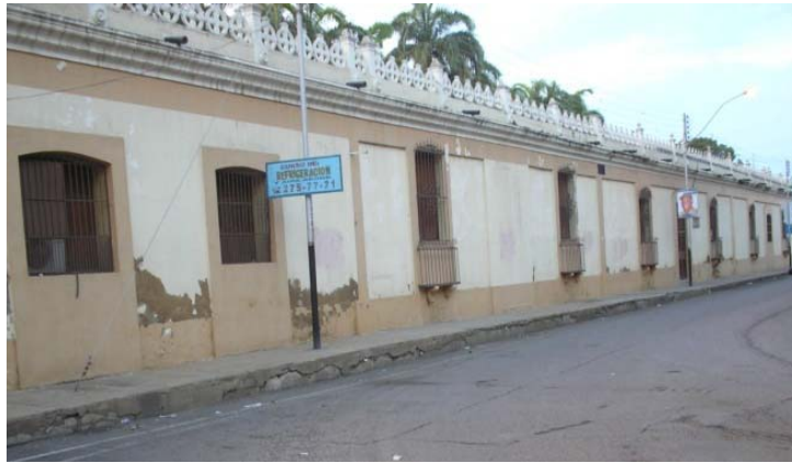
Figura n°55 Fachada principal oficinas del ferrocarril, Escuela “María Rosa Molas”, 2008.
