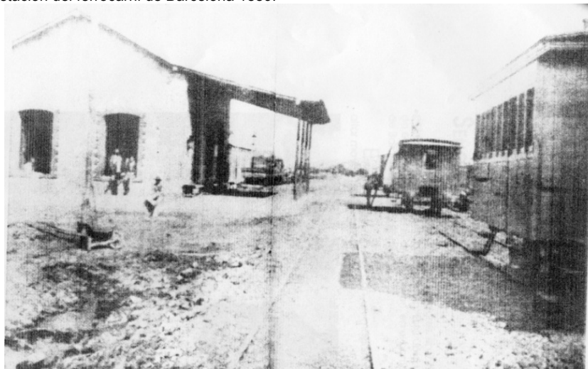
Figura n°51 Estación del ferrocarril de Barcelona 1889.
