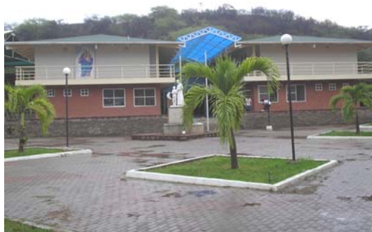
Figura n°9. Casa Hogar Don Bosco, vista del modulo de habitaciones.
