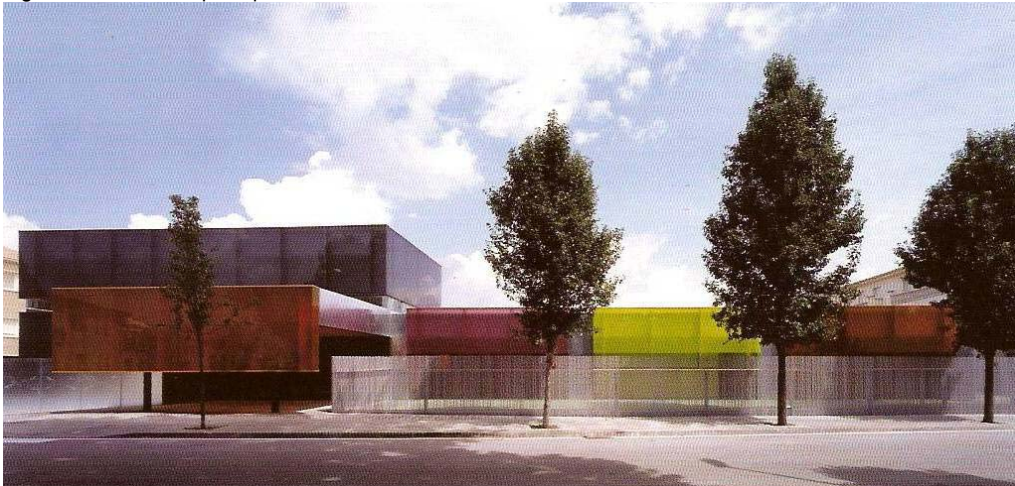
Figura n° 1. Fachada principal, Guardería “Els Colors”.
