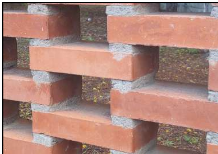
Figura 2.2 Detalle Intercalado de ladrillos en cerco perimetral
