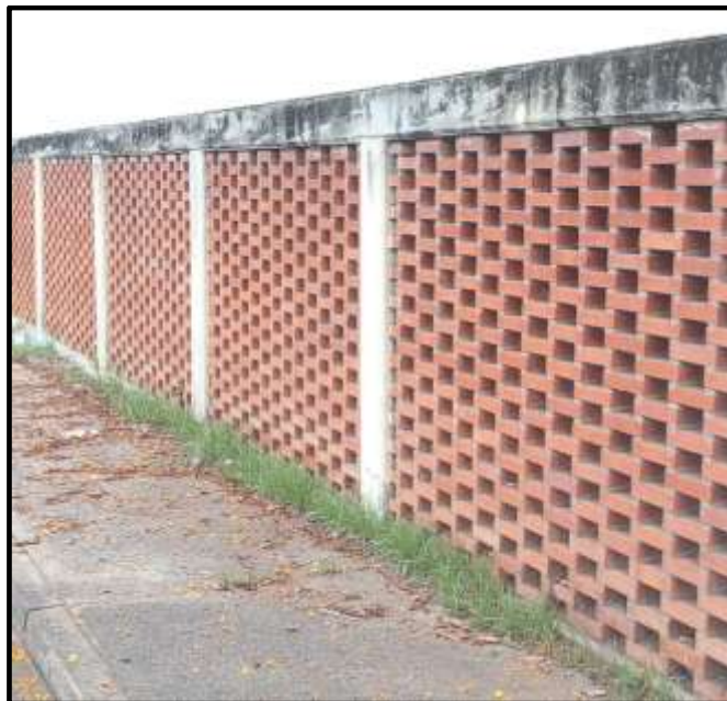
Figura 2.1 Cerco perimetral Escuela Ciencias de la Tierra
