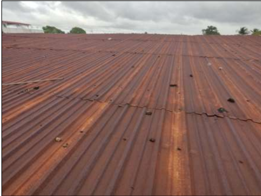
Figura 5.5 Fotografía de la cubierta del techo del galpón.
