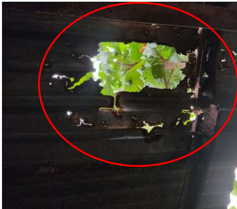
Figura 5.6 Fotografía de la cubierta del techo del galpón.
