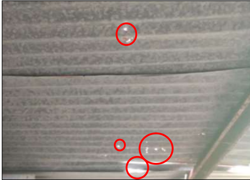
Figura 5.7 Fotografía de la cubierta del techo del galpón.
