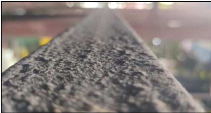
Figura 5.15 Fotografía de elementos estructurales corroidos del galpón.
