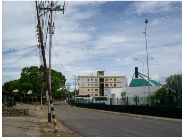
A.3 Vista lateral izquierda del inmueble
