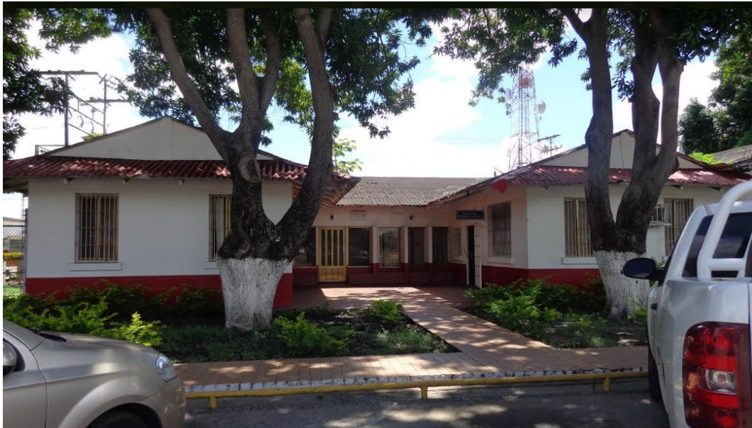
Figura 3. Edificio de Desarrollo Urbano EN7. Fuente: Autor.
