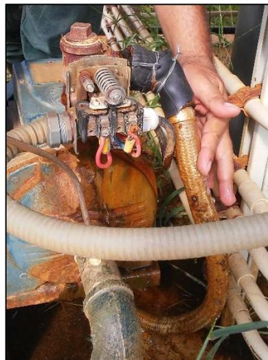
Figura 19. Conexión de Bomba Hidroneumática con fuga. Fuente: Autor.
