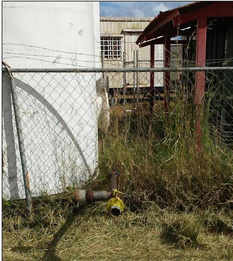
Figura 20. Conexión de 4 pulgadas para cisternas. Fuente: Autor
