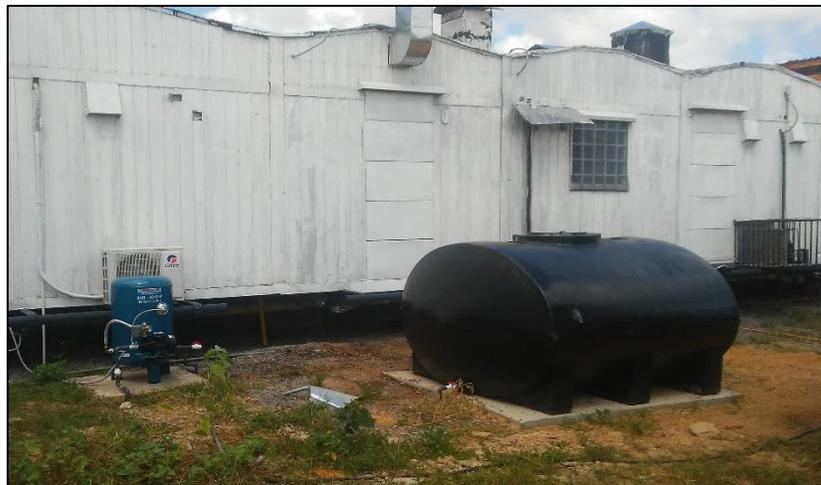
Figura 22. Bomba y Tanque de Almacenamiento para la Cocina, Comedor y Sanitarios. Fuente: Autor.
