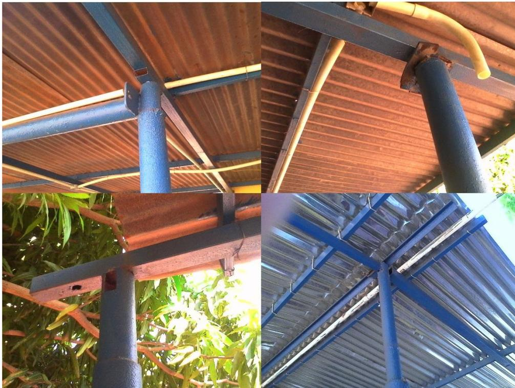
**Figura 29. Conexiones entre vigas y columnas del edificio de almacén y vigilancia de la empresa Constructora 3 AMG, C.A. Fuente: Autor.**
