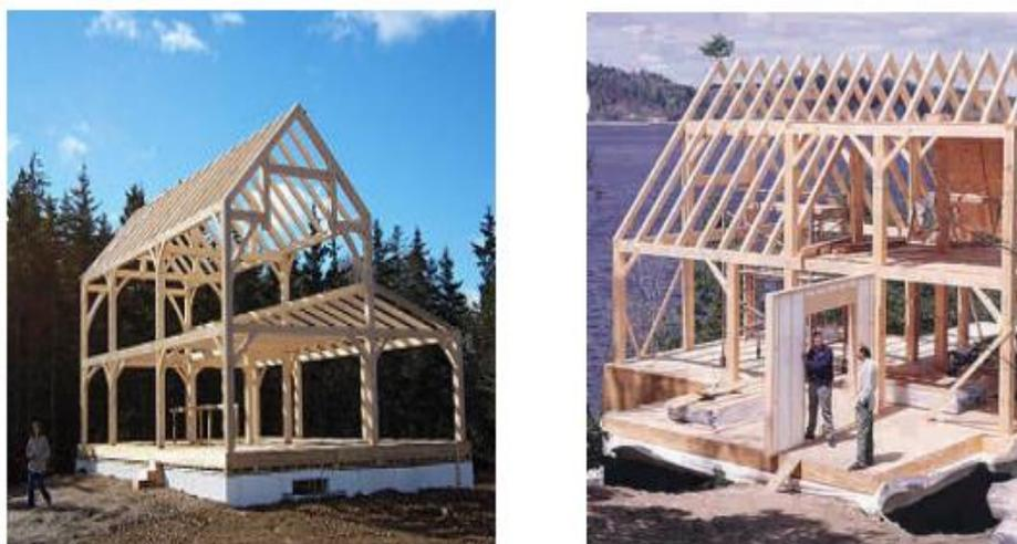
**Figura 23 Estructura con elementos de pino caribe**
