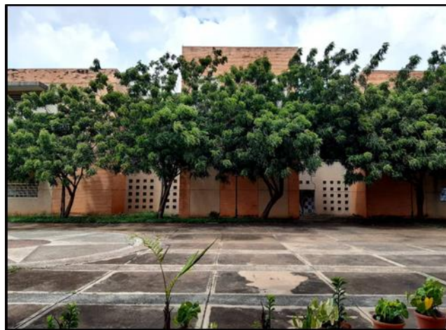
Figura 1. Fachada delantera de los módulos de la Universidad de Oriente Extensión Cantaura. Fuente: Autor.
