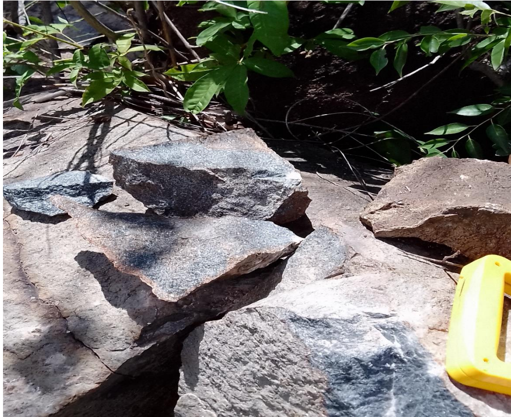
Figura 4.5 que muestra a la vegetación arraigada en el afloramiento y las fracturas o diaclasas en el macizo rocoso.
