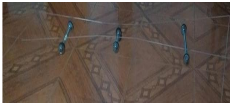
Figura 20. Refuerzo de paredes con barras roscadas
