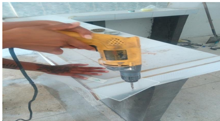
Figura 18. Perforado de paredes de la canaleta Parshall. Fuente: Autor.
