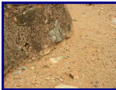
Gráfico 46: Bases o cimientos de la edificación agrietadas y desmoronándose.
