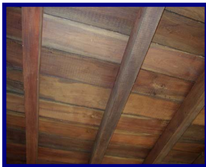
Gráfico 17: Vista del techo actual (interno).
