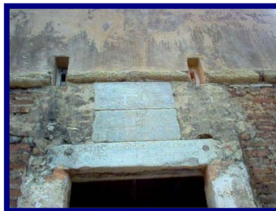
Gráfico 44: Fogonaduras o hendiduras.
