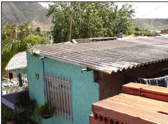
Figura nº 7- Techos de asbesto en las viviendas de La Galera
