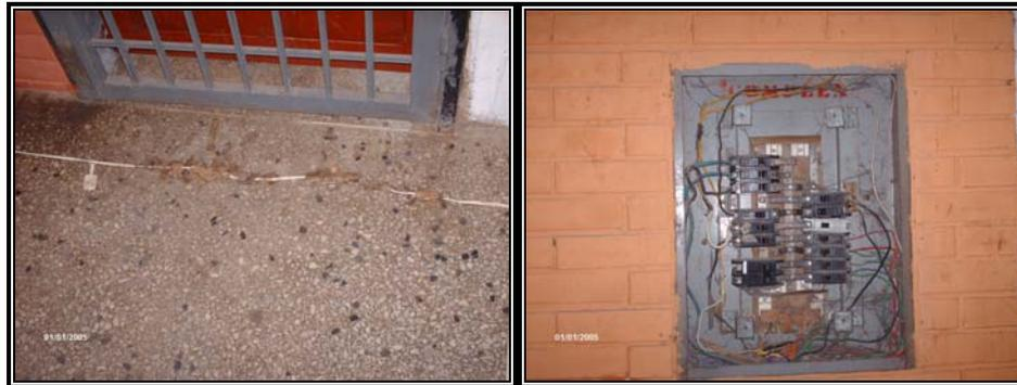
Figura 5.5 Cableados energizados expuestos en los pasillos
