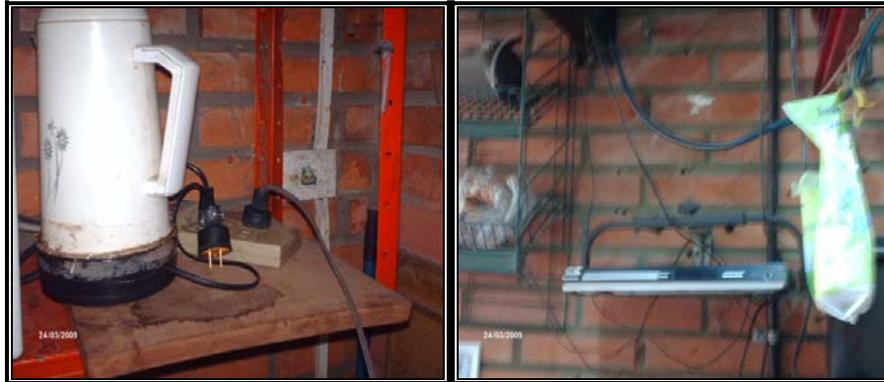
Figura 5.22 Muestra los cables sueltos
