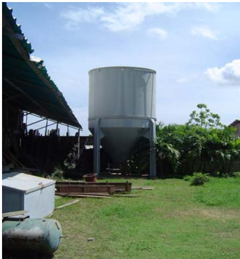
Figura 4.4. Tanque central de agua
