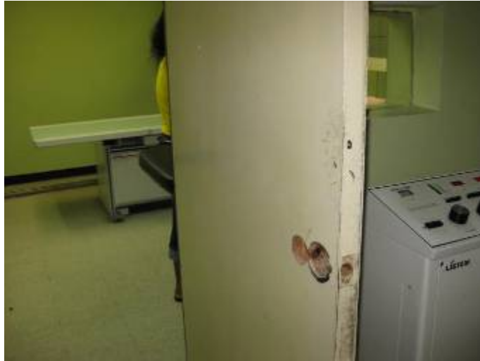
Figura 4.16. Puerta que separa el cuarto de la máquina de toma de rayos x del técnico radiólogo.
