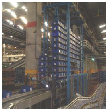
Figura 4.13 Acumulador de cajas vacías
