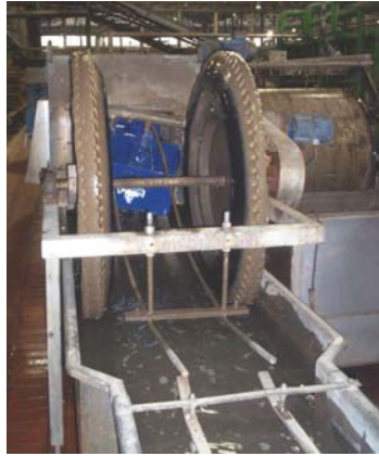
Figura 4.15 Lavadora de cajas
