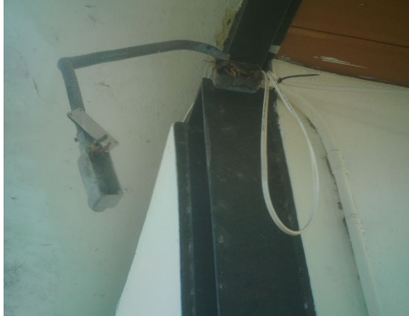
Cableado desprotegido
