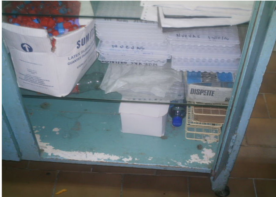
Gabinetes obsoletos y acumulación de basura.
