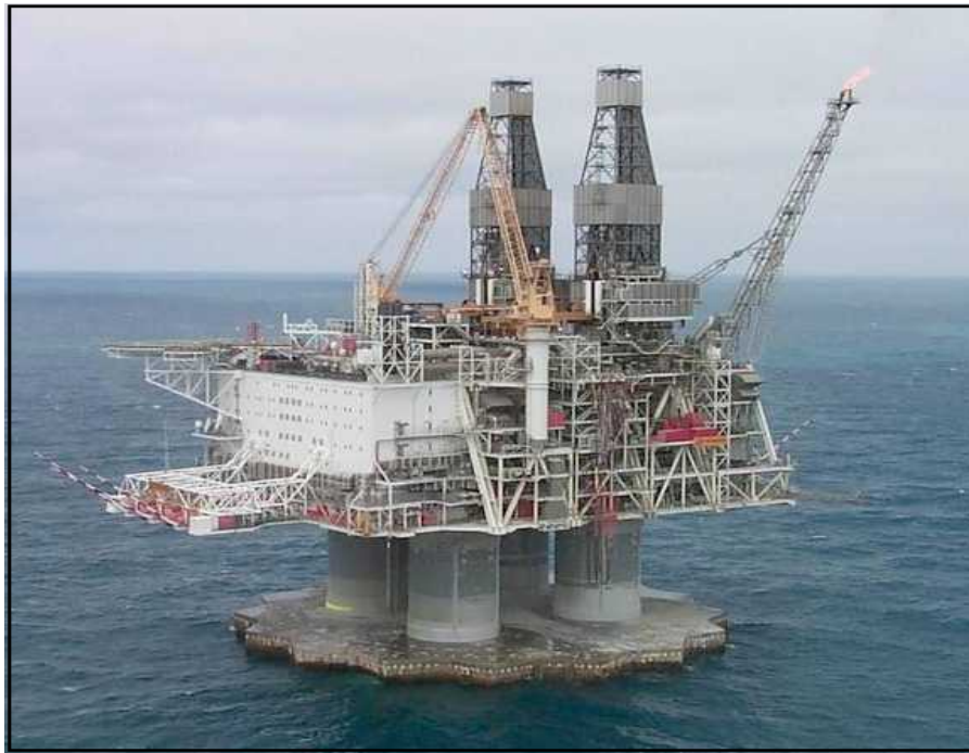
Figura 2.3 Plataforma de concreto.
