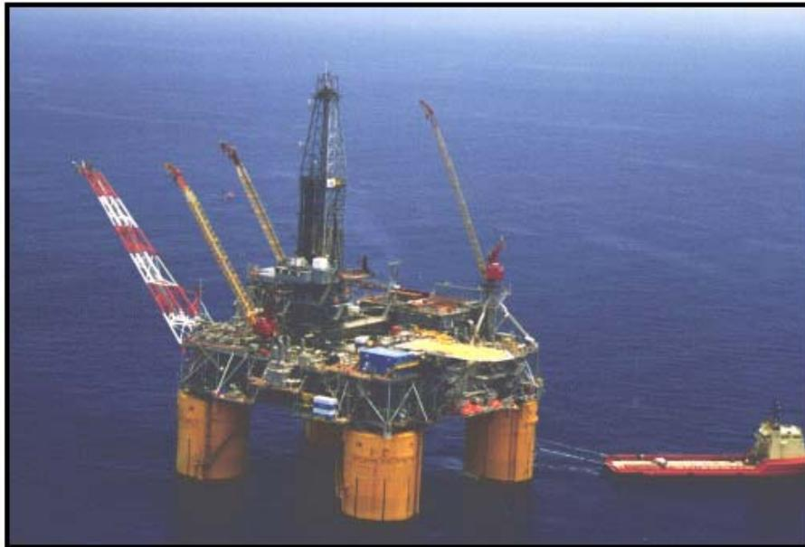
**Figura 2.5** Plataforma de patas tensionadas.
