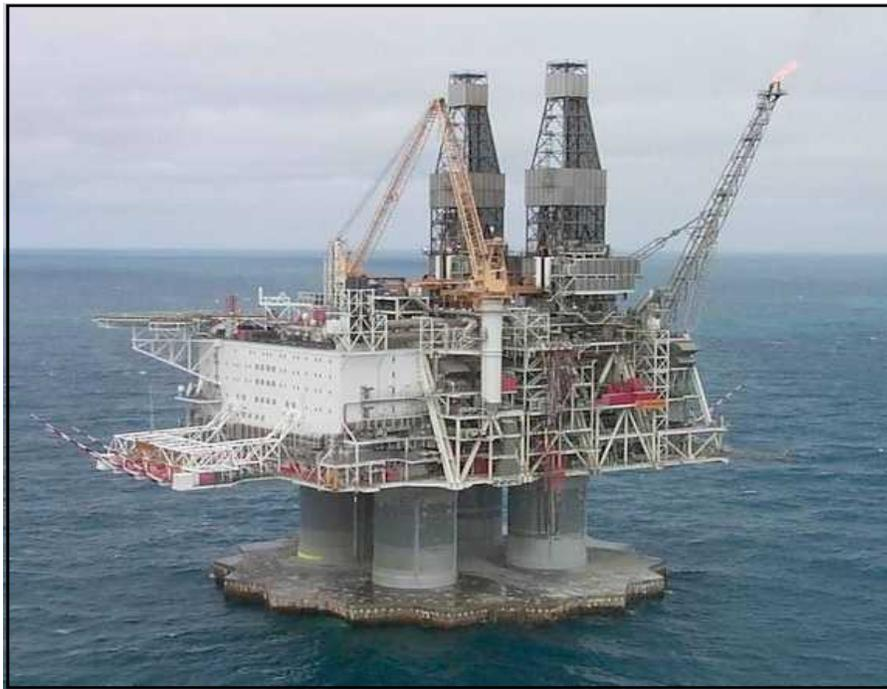
**Figura 2.3** Plataforma de concreto.
