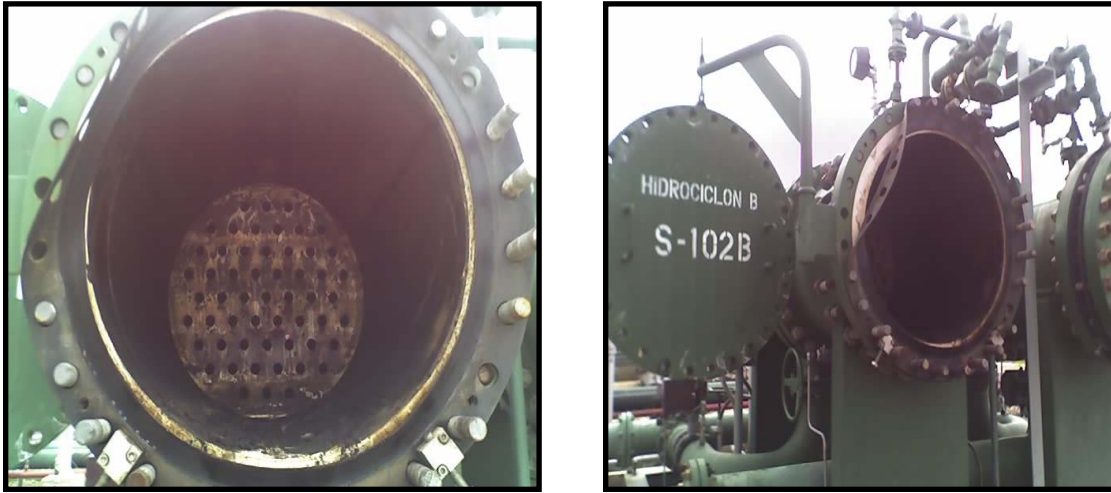
Figura 4.2.- Estructura interna del hidrociclón
