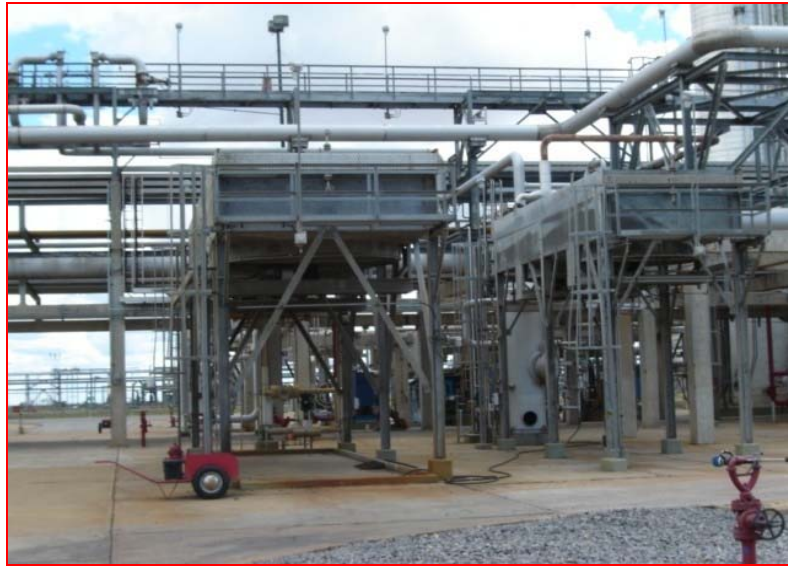
Figura 4.7 Vista del Aeroenfriador.
