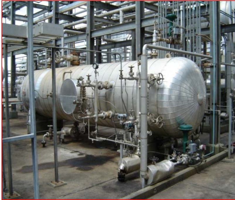
Figura 4.5 Equipo Flash Tank de glicol.
