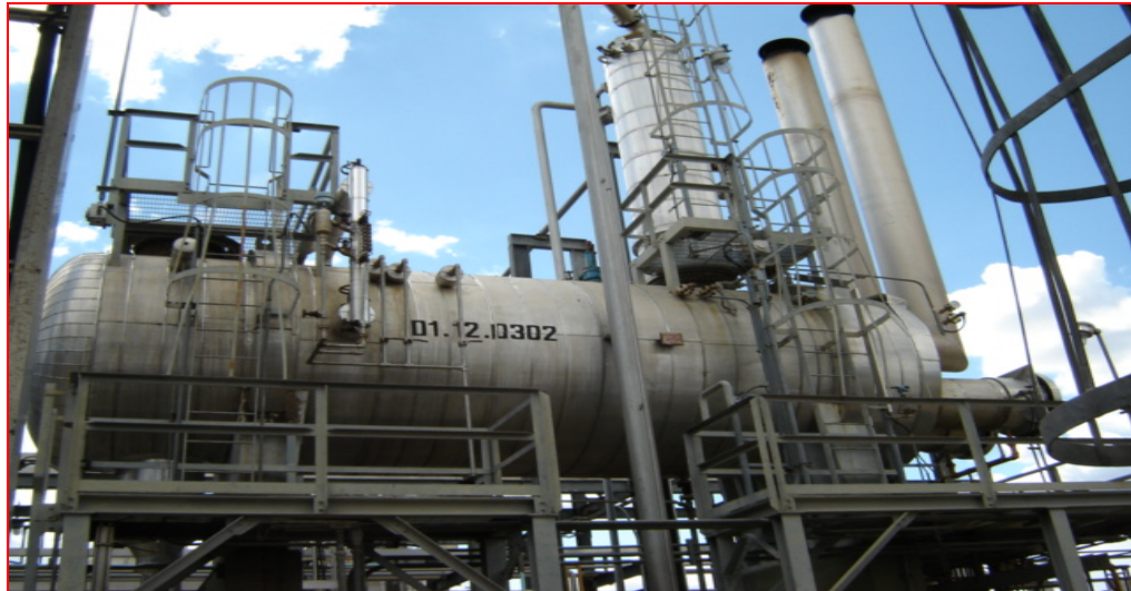
Figura 4.3 Rehervidor de Glicol.
