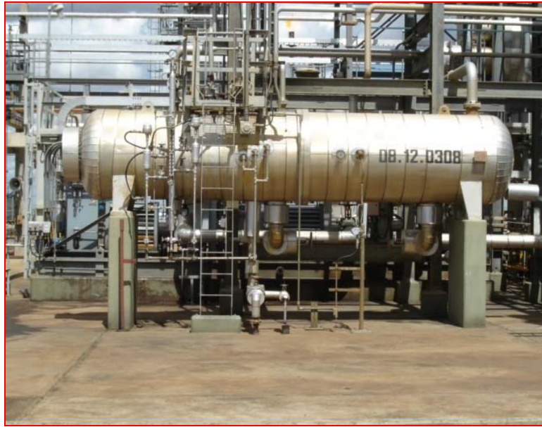
Figura 4.6 Vista frontal del acumulador de glicol.
