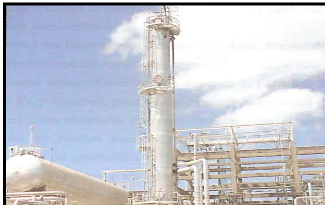
Figura 4.17. Torre estabilizadora de Condensados
