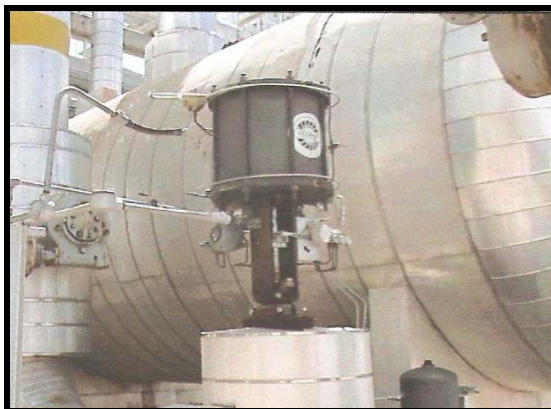
Figura 4.12 Válvulas J-T de alta presión
