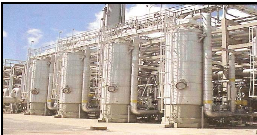
Figura 2.10 Sistema de deshidratación con tamices moleculares
