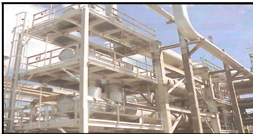
Figura 4.11 Intercambiador gas caliente-gas de alta presión.
