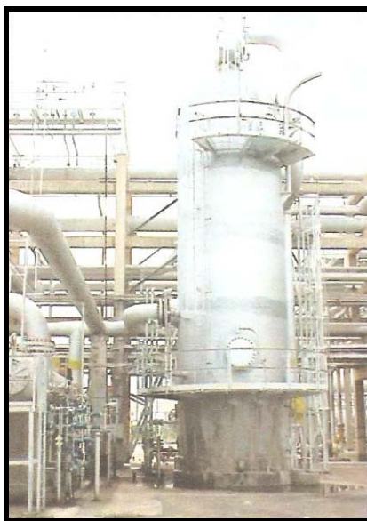
Figura 4.10. Torre contactora de trietilenglicol.
