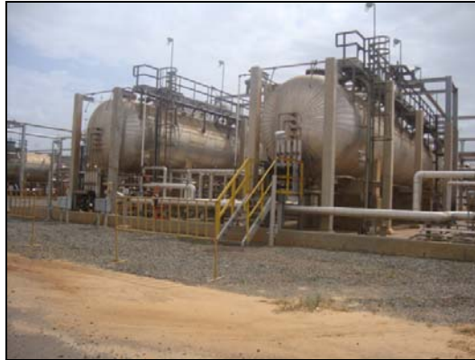
Figura 2.9 Tren de deshidratación/desalación
