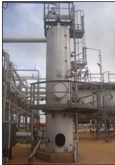
Figura 2.2 Depurador de gas
