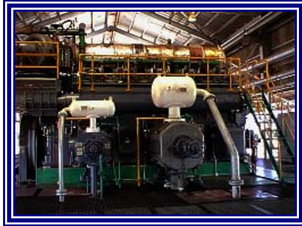
Figura 2.11 Compresor centrífugo, perteneciente a la planta compresora Zapato.
