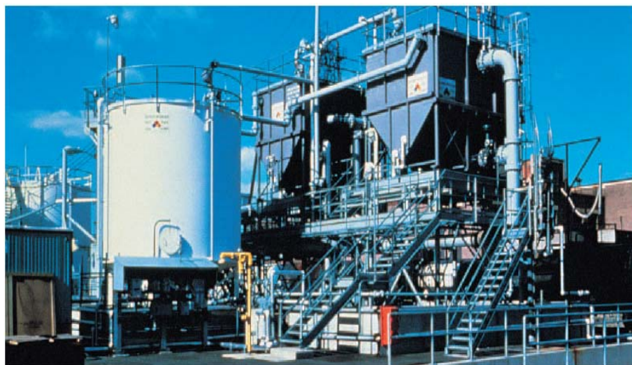
Figura 2.1 Separador de placas corrugadas CPI (Salazar, 2006)
