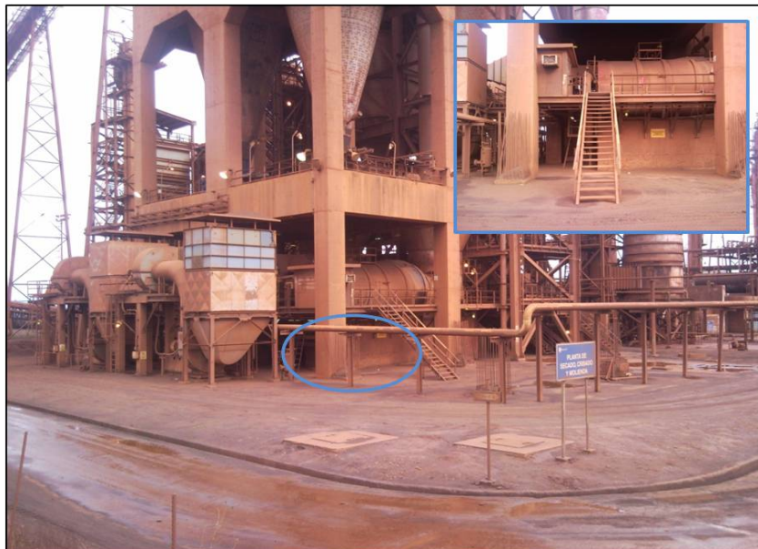
Figura 4.8. Ubicación seleccionada para las pruebas de inyección de ALU en la cámara de combustión del Secador B de Orinoco Iron.
