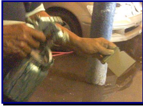
Figura 4.3 Aplicación de la pintura acrílica con la pistola a una presión de 30 Lb.
