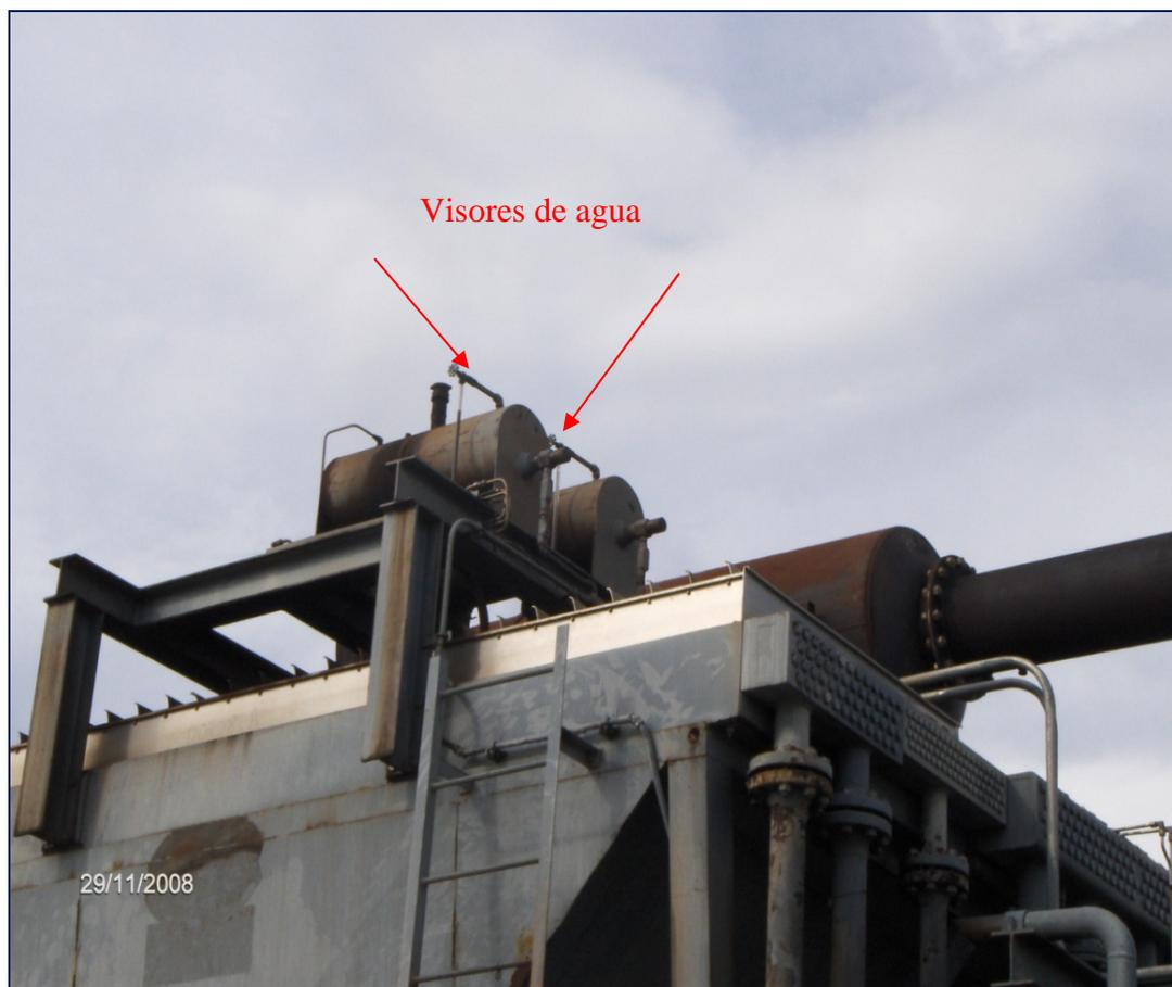
**Figura 4. 2.** Tanques de compensación de la unidad motocompresora M-2 y sus respectivos visores de agua.
