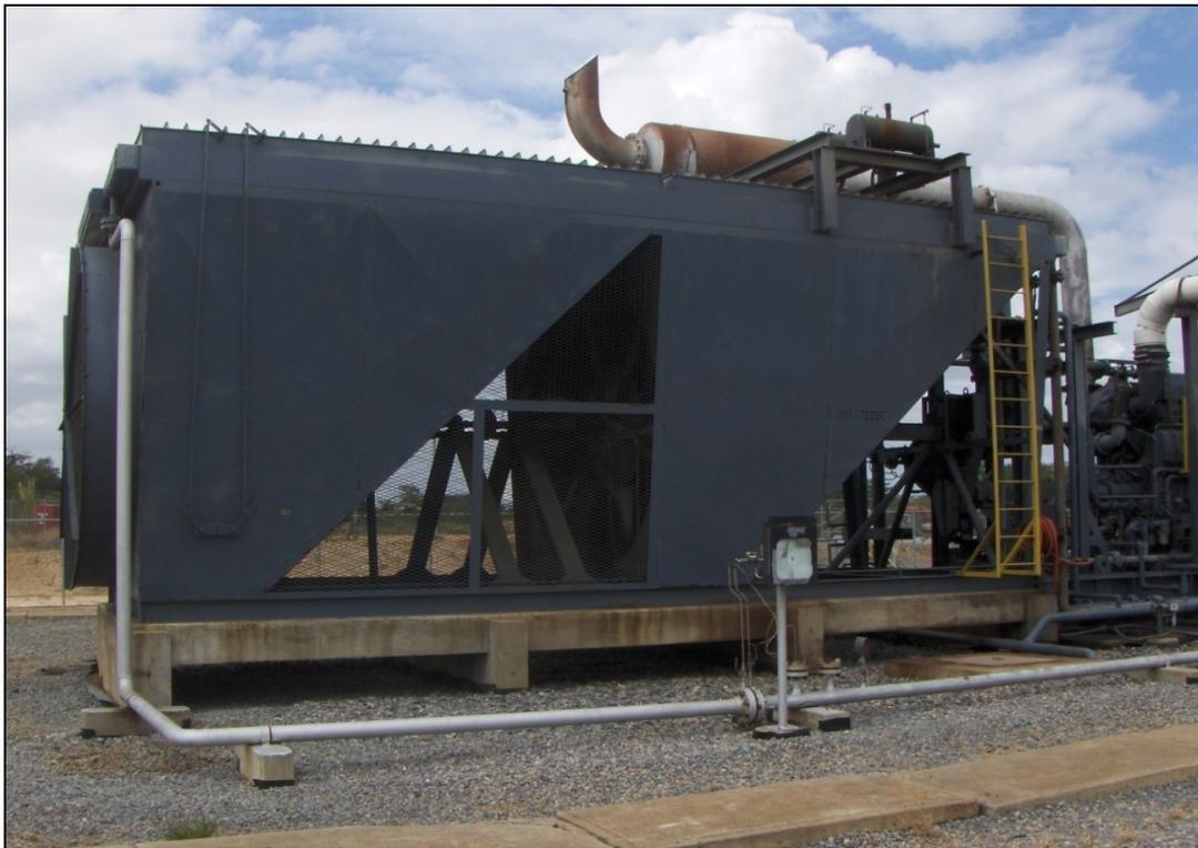
**Figura 2. 6.** Enfriadores por aire atmosférico
