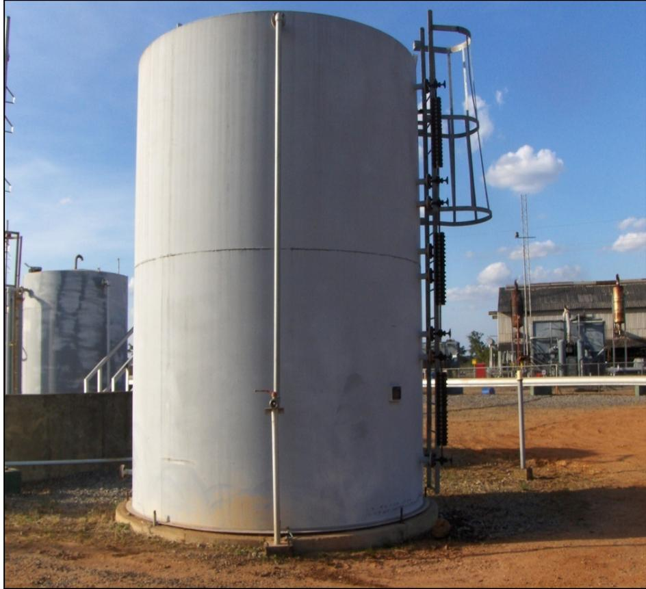
**Figura F. 1.** Tanque de almacenamiento de agua de alimentación de las unidades motocompresoras de zorro nuevo
