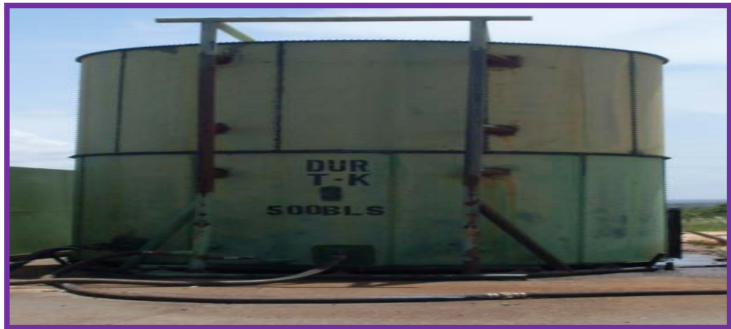
Figura 3.4. Tanque de almacenamiento de agua dura.
