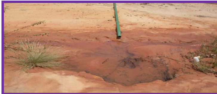
Figura 3.17. Descarga de la solución producto de la regeneración de la zeolita.
