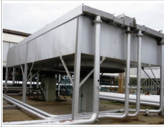
Figura 2. 5. Enfriador por aire de tiro forzado
