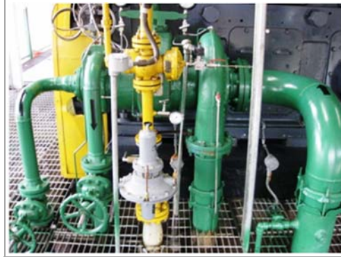
Figura 2. 4. Bomba centrífuga engranada al motocompresor
