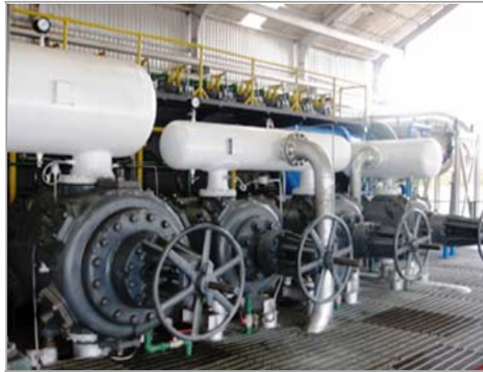
Figura 2. 3. Motocompresor reciprocante
