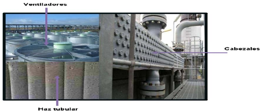
**Figura 2.3 Componentes de los enfriadores por aire.**
