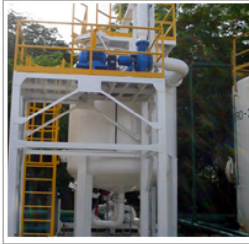
Figura 2.6. Vista externa de un filtro de cáscara de nuez [21].
