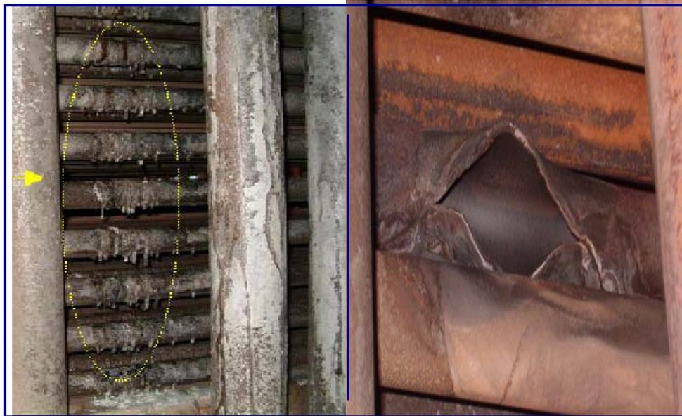
**Figura 4.2 Incrustaciones y rupturas de los tubos de los sobrecalentadores de la caldera.**
