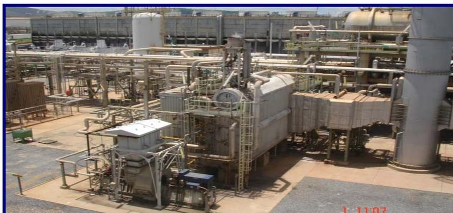
**Figura 2.6 Caldera (32-B-601) acuotubular de circulación natural generadora de vapor de alta presión (HS).**
