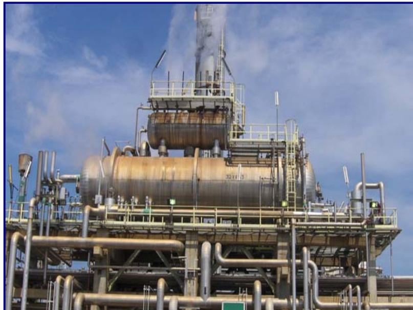
**Figura 2.11 Desaireador (V-603) de agua de alimentación para caldera.**
