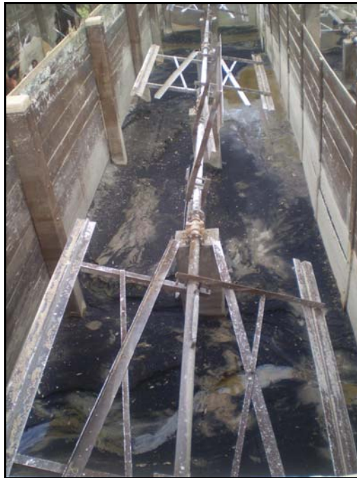
Figura 3. 11 Ubicación de pares de paletas en el eje.
