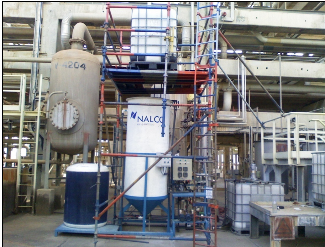
Figura 3.22 Instalación de un tanque ecualizador y tanque de mezcla lenta.
