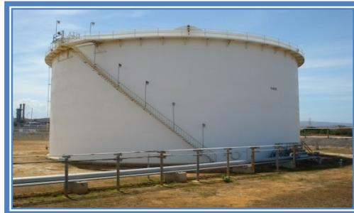
Figura 2.5 Tanque atmosférico de techo flotante. <sup>[4]</sup>
