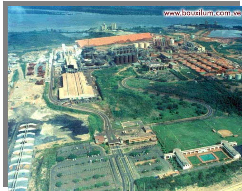
Figura 1.1 Vista aérea de la empresa C.V.G. Bauxilum [1]
