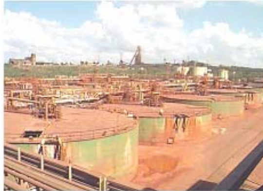
Figura 1.6 Tren de espesadores y lavadores (área de sedimentación y lavado de lodo rojo)
