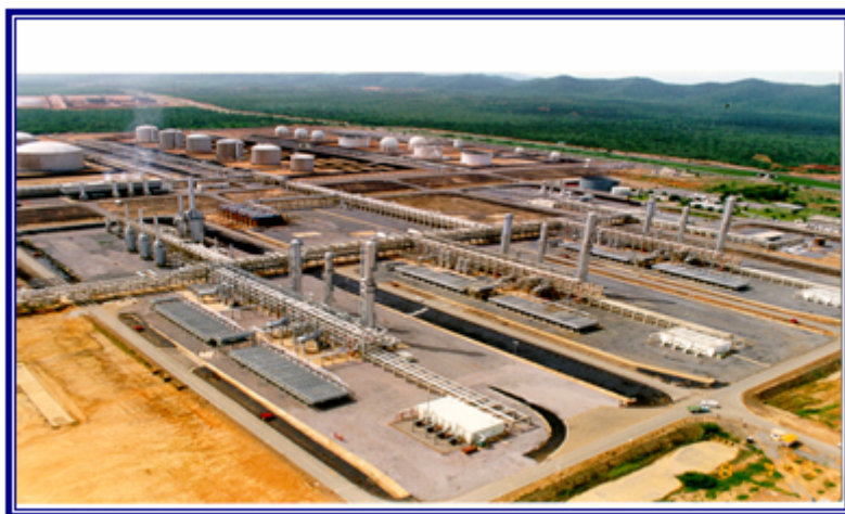
Figura 1.1: Vista de la Planta de Fraccionamiento y Despacho Jose (PDVSA Gas)
