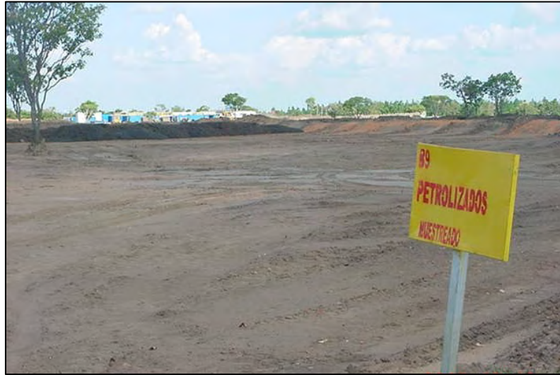
Foto 7. Celdas de para el tratamiento de ripios mediante Landspreading
