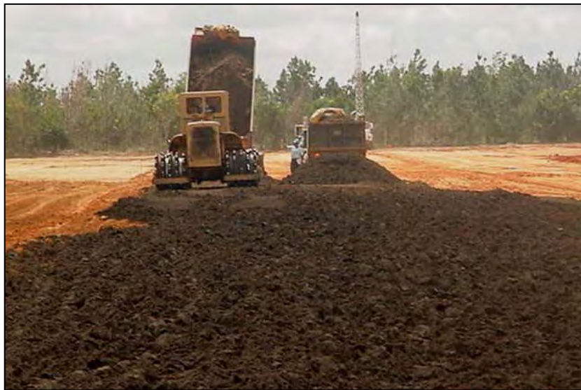
Foto 10. Utilización de ripios ya tratados como material para la construcción de macollas
