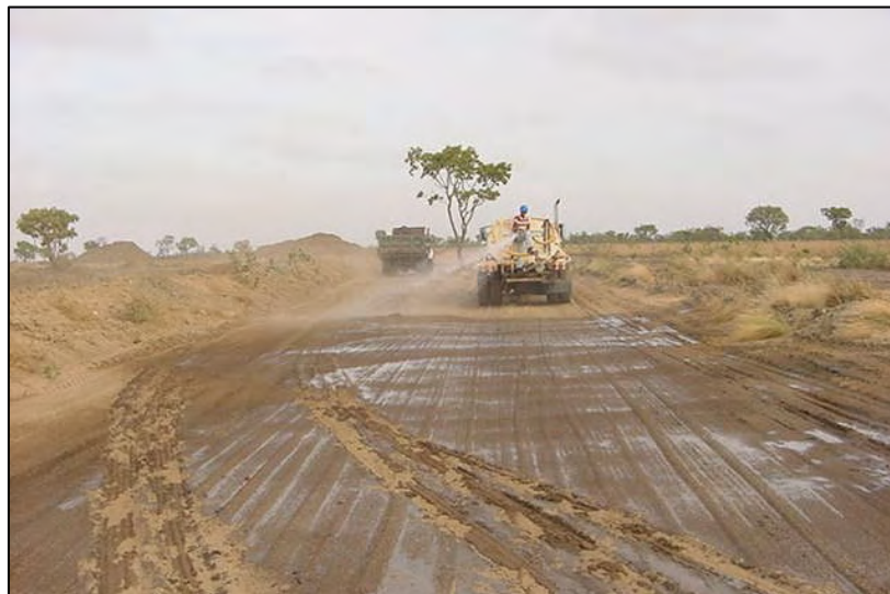
Foto 12. Asperjado con aguas tratadas para el control de polvo en el CTRD
