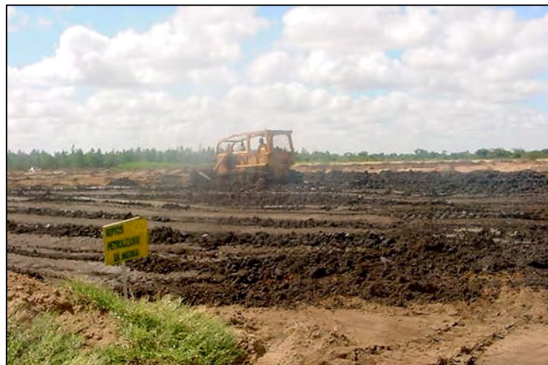
Foto 8. Esparcimiento de ripios para secado en las celdas de tratamiento
