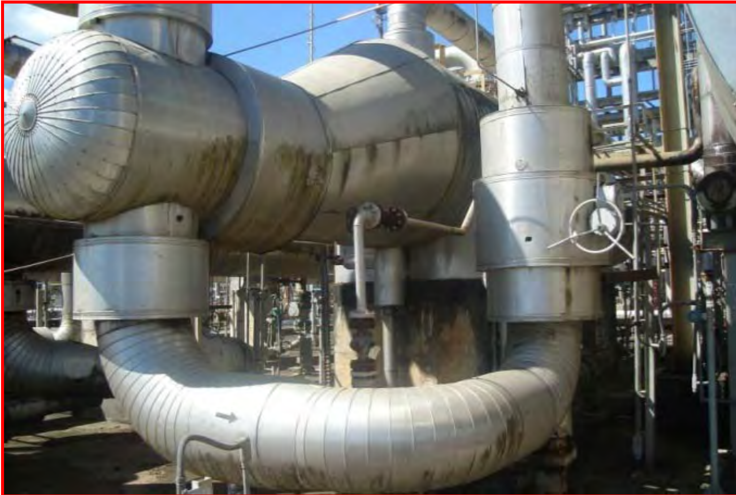
A.6 “Enfriamiento del gas seco”
