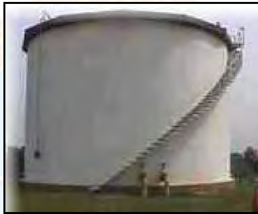
Figura 2.8 Tanque de Techo Flotante Fuente: Metal Mec. (2007)
