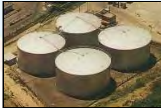
Figura 2.7 Tanque de Techo Fijo.
