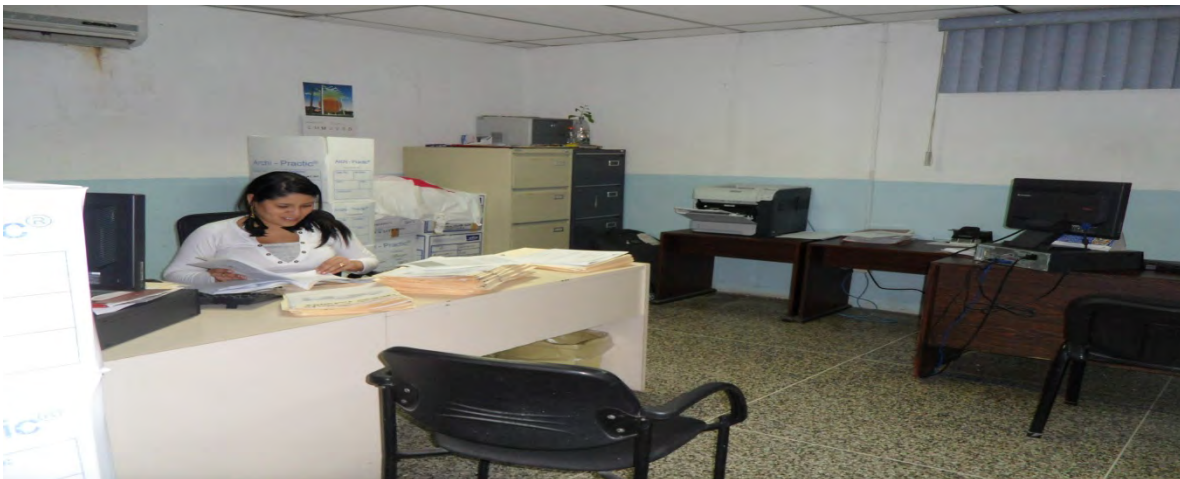
AIRE ACONDICIONADO SIN FUNCIONAR
