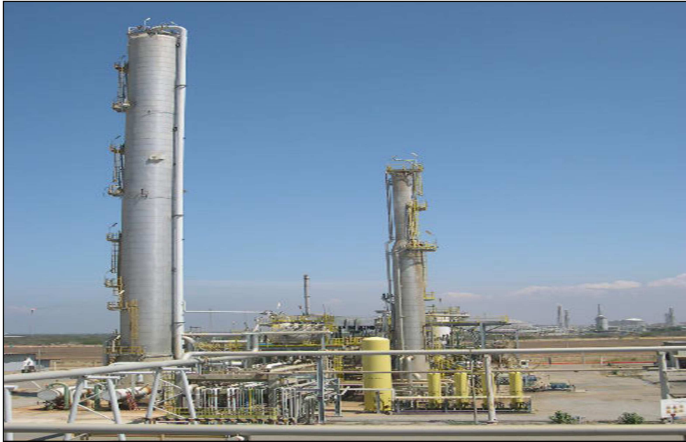
Figura 2.2 Vista parcial de las unidades de isomerización y desisobutanizadora.
