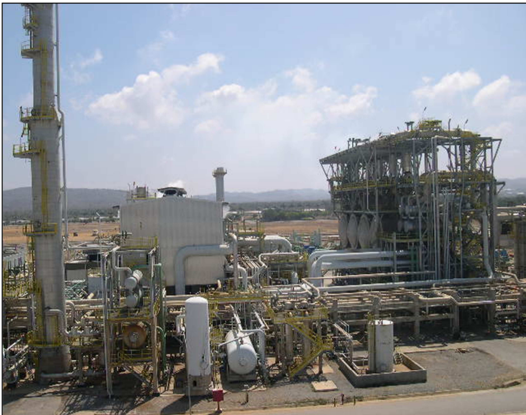
Figura 2.3 Vista parcial de la unidad de deshidrogenación.
