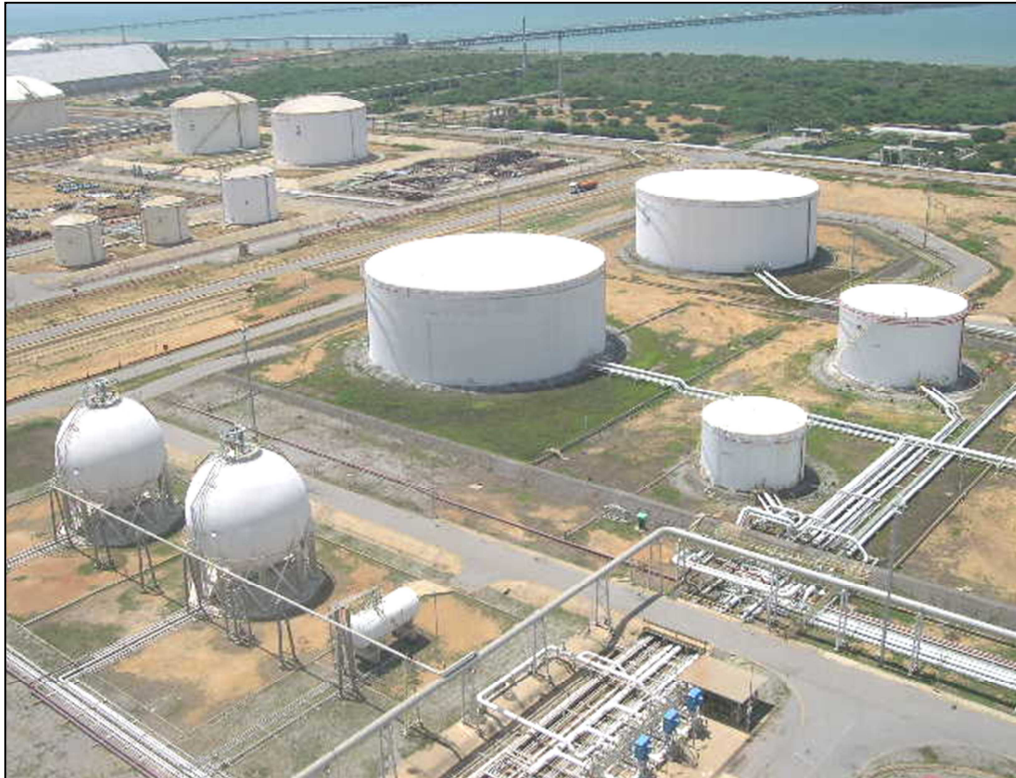
Figura 2.5 Unidad de almacenamiento.
