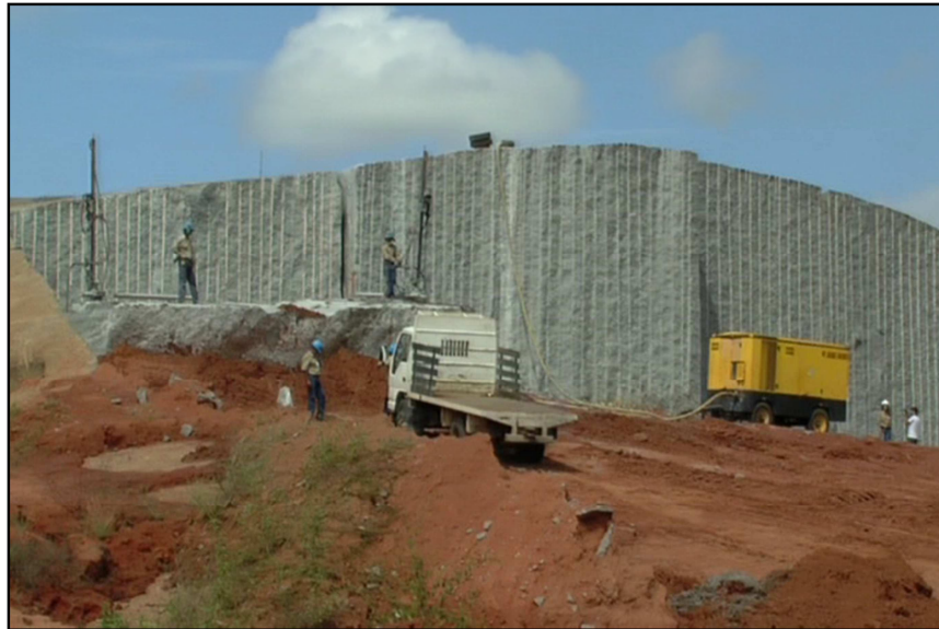
Figura 5.7 Corte de bloques con cemento expansivo (EXPIGUA, Cantera la Leona 2010)
